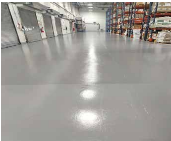
RESANE, PINTURA Y SEÑALIZACIÓN DEL PISO DEL ALMACÉN CEDIS
