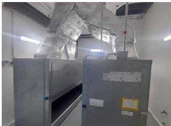
EVAPORADORES 20 TON C/U ULAPS CARLOS VELARDE
