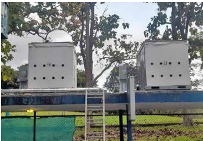
CONDENSADORES 10 TON C/U PEDIATRÍA POLICLÍNICA CALOS N. BRIN
