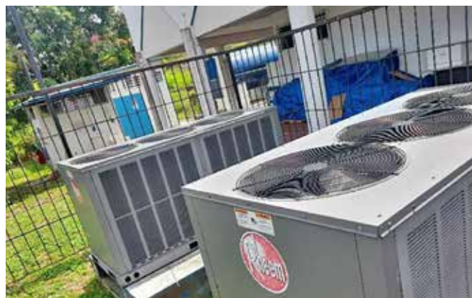
CONDENSADORES 20 TON C/U ULAPS CARLOS VELARDE
